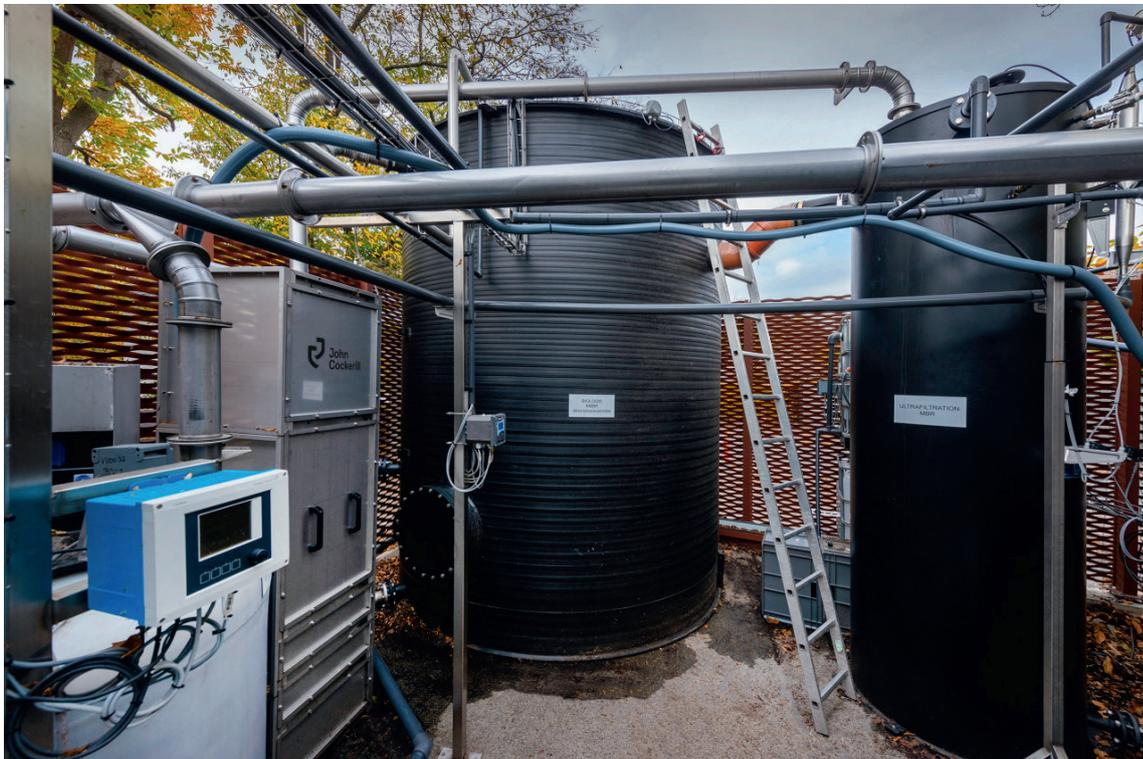
La cuve centrale permet le traitement biologique et la cuve de droite abrite la filtration membranaire. Le boîtier de gauche est un transmetteur qui collecte les mesures de différentes sondes. L'armoire métallique sert à purifier l'air vicié qui est collecté en partie haute des différentes cuves.
